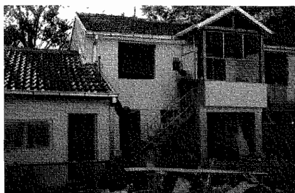
Chiesa avventista in costruzione a Skopje, Macedonia.
